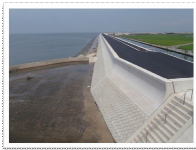
緑川海路口地区築堤工事 高潮災害対策(防波堤防嵩上げ)
