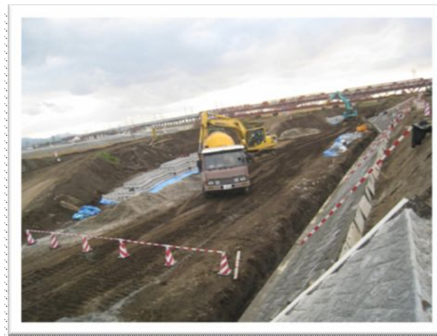
白川蓮台寺地区築堤護岸工事 洪水対策(川幅の拡幅及び新しい堤防の設置)
