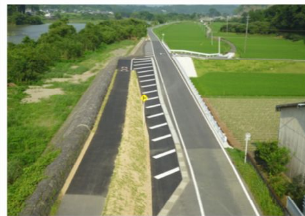
緑川上揚地区宅地嵩上築堤護岸工事 地区集落の輪中洪水対策(護岸の嵩上げ)
