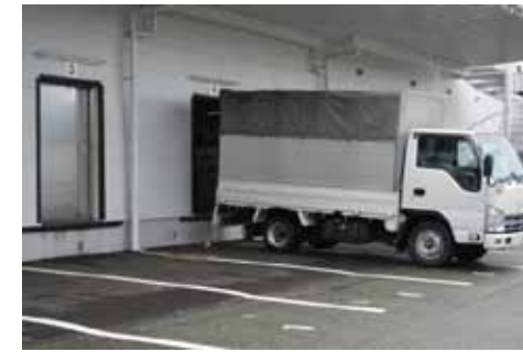
作業場（冷蔵庫）からトラックへ、直に荷出し積み込みができるようになっています。トラックの荷台への上り下りによって生じるスタッフの足腰の負担を軽減します
